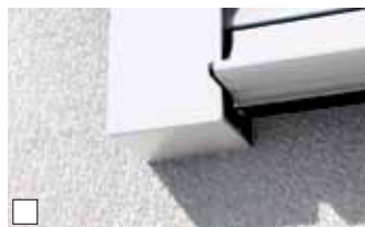
Die unten geschlossene Führungsschiene wird benötigt, wenn sie ohne Anschlag frei montiert ist.
